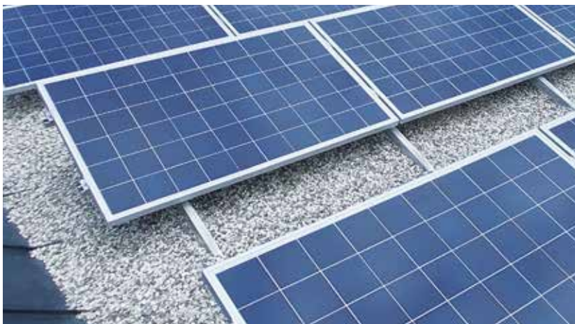
Elpo | Seis - Italie Installation: 5,76 kW | Système Triangle K2
